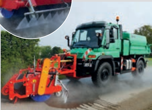
SFK mit Aufkratzeleiste, Wasserhochdruckanlage und Schwemmbalken
