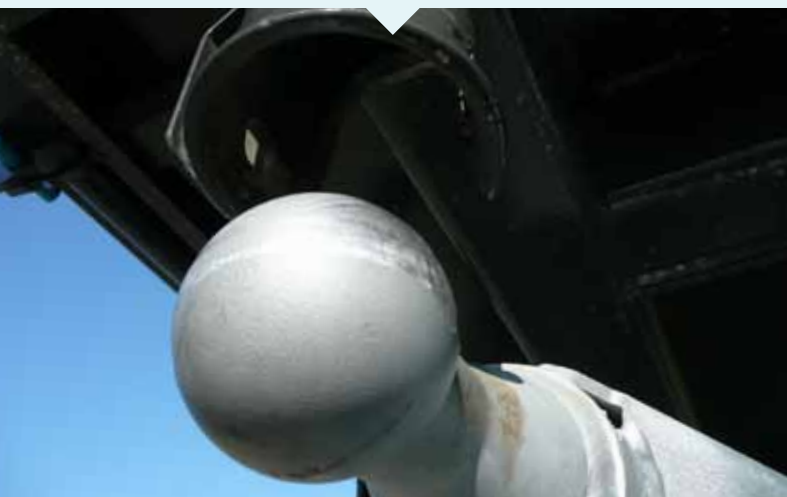
Kugelkipplager.
